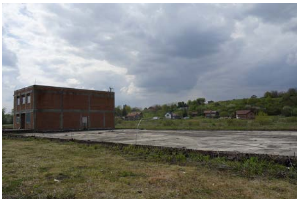
Slika 18: temeljna ploča proizvodne hale
